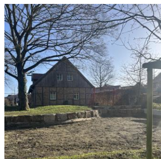
Hier entsteht gerade ein neuer Spielplatz im Park am Heimatverein.
